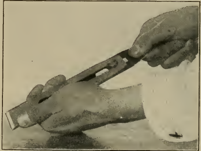
Fig. 106—Sliding Cap Iron
